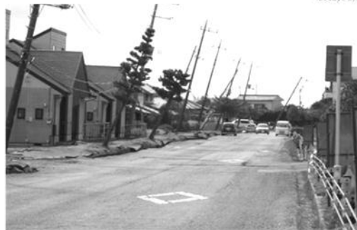
図-6 千葉県潮来市内の液状化状況 (東京電機大学地盤工学研究室)
